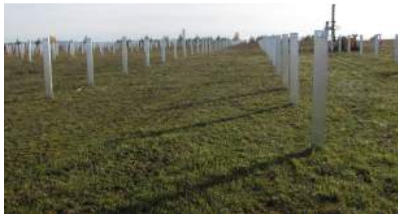
Photo 9 : Exemple de pieux battus dans le sol avec une batteuse visible en arrière-plan
