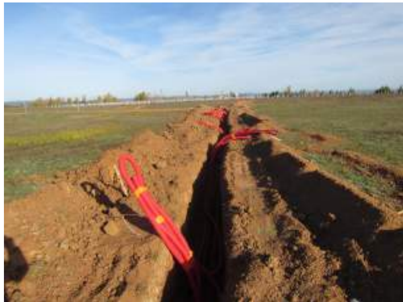
Photo 8 : Exemple de tranchée et pose de câbles dans des fourreaux
