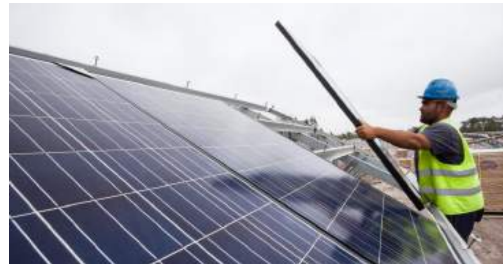
Photo 11 : Pose de modules
