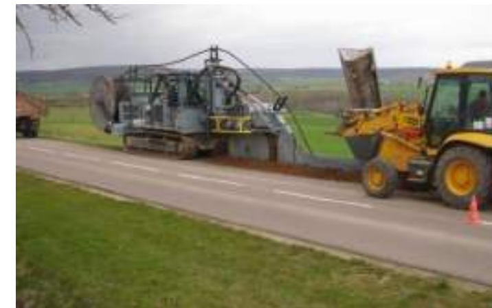
Photo 6 : Réalisation d'une tranchée
