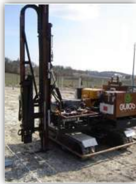
Photo 2 : Engin de battage de pieux
