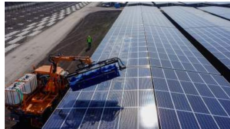
Photo 13 : Exemple de procédé de nettoyage des modules
